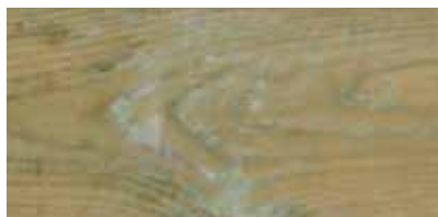
Residui del trattamento in autoclave
