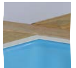
Ziehen Sie den Liner in die Ecken gut fest Tendere bene il liner negli angoli Span de liner strak in de hoeken Estique bem liner nos cantos
