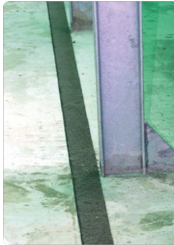
Figura 8 – Instalación de tiras bituminosas
