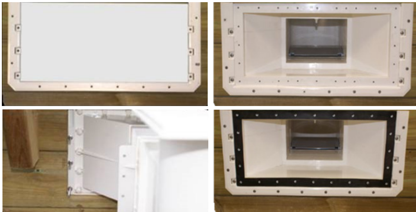
Figura 22 – Montaje del skimmer
