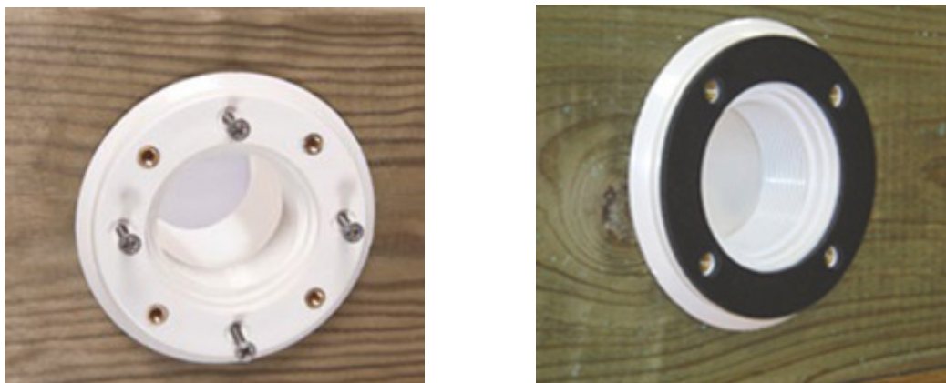
Figura 24 – Montaje del cuerpo de la boquilla de retorno y su junta
