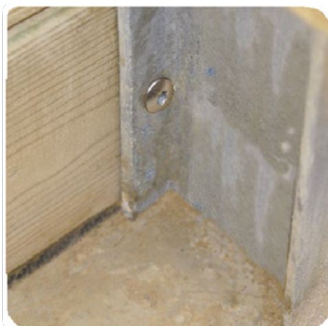
Figura 11 – Bloqueo de tablonos en los puntales
