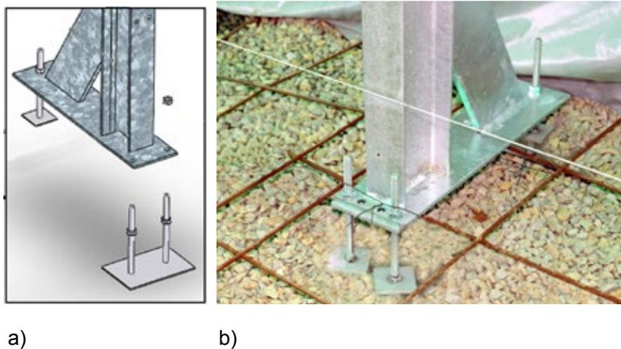
Figura 3 – a y b - Colocación de cilindros en los puntales
