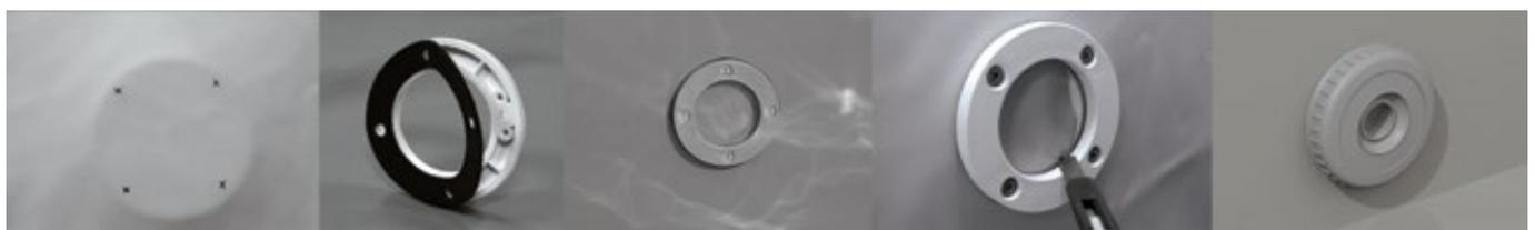
Figura 34 – Montaje de la brida sobre el retorno
